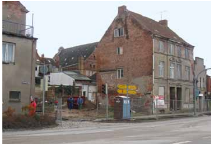
Wasserstraße 3/Ecke Fischerstraße, unsaniert
