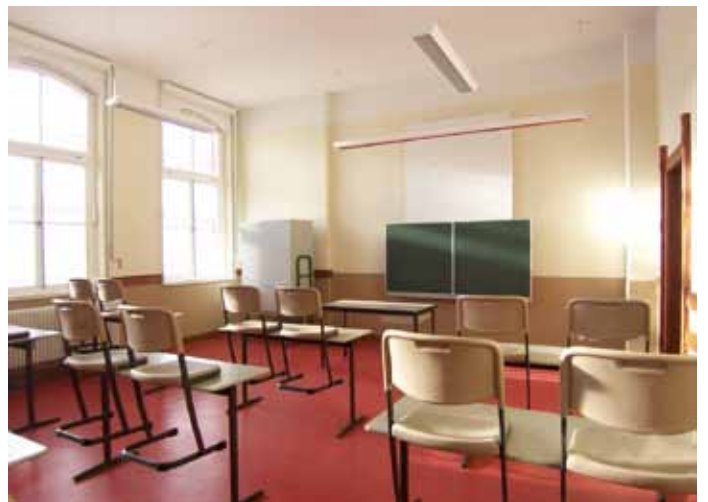
Klassenraum nach der Sanierung
