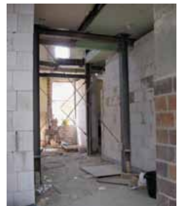
Sicherungsmaßnahmen durch Stahlträger
