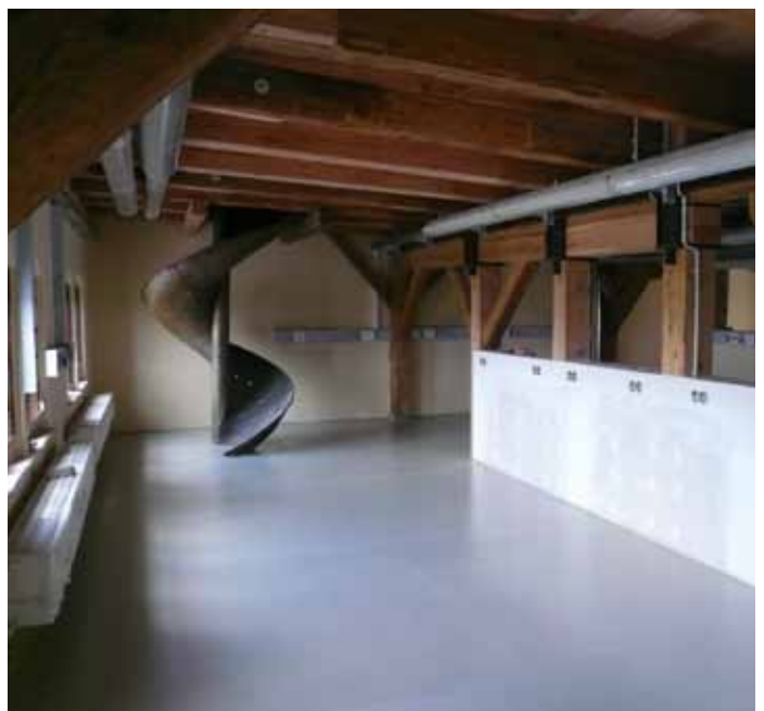
Arbeitsraum mit sichtbarer Holzkonstruktion und gewendelter Sackrutsche
