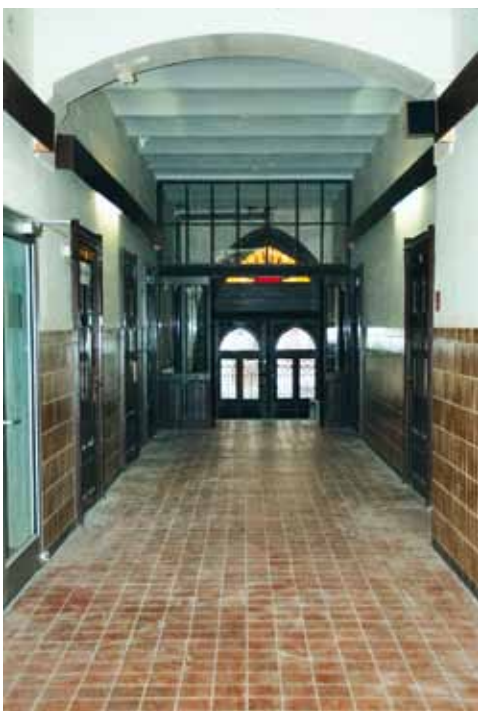
Flur vor der Sanierung im EG
