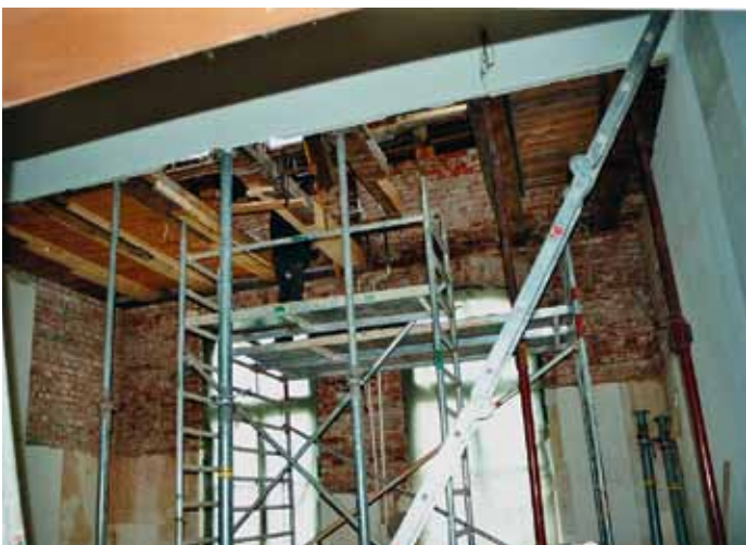
Klassenraum während der Sanierung
