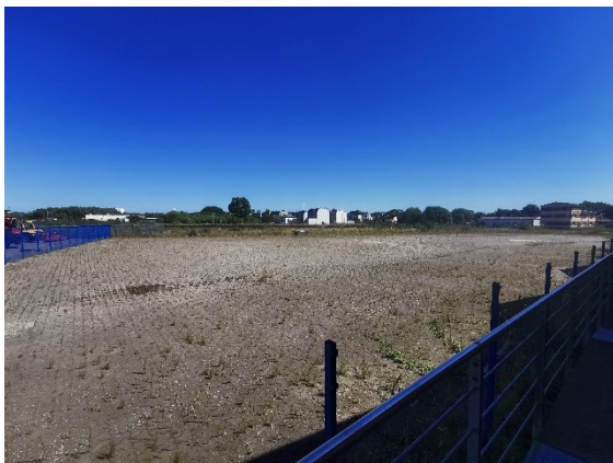
Foto 3: Blick auf die versiegelten ehemaligen Bahnbetriebsflächen
