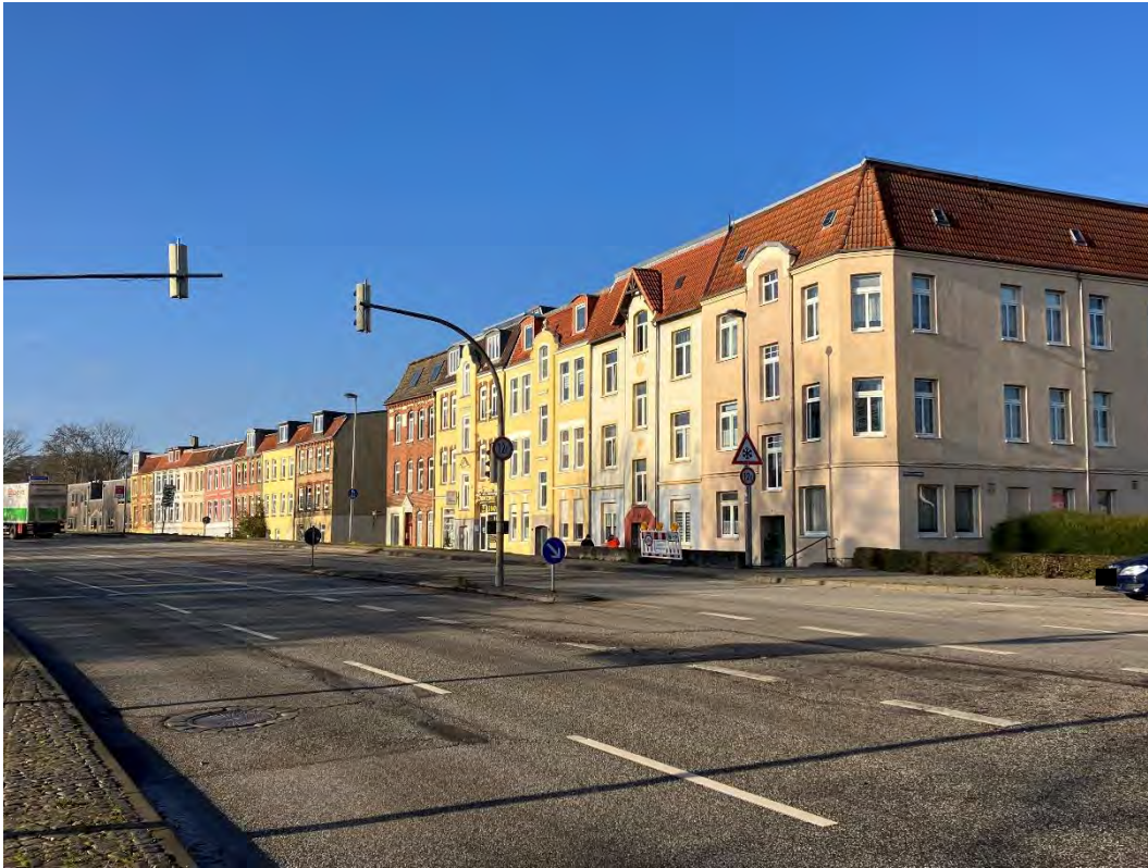
Abbildung 19: Lärmbetroffene Gebäude Rostocker Straße
