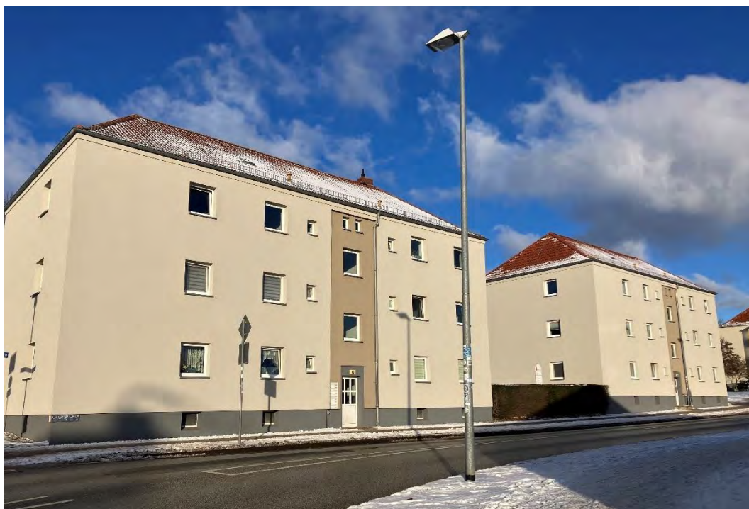
Abbildung 21: Lärmbetroffene Gebäude Rudolph-Breitscheid-Straße
