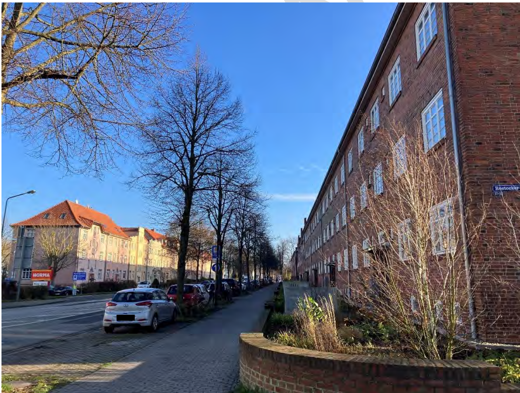
Abbildung 20: Lärmbetroffene Gebäude Rostocker Straße
