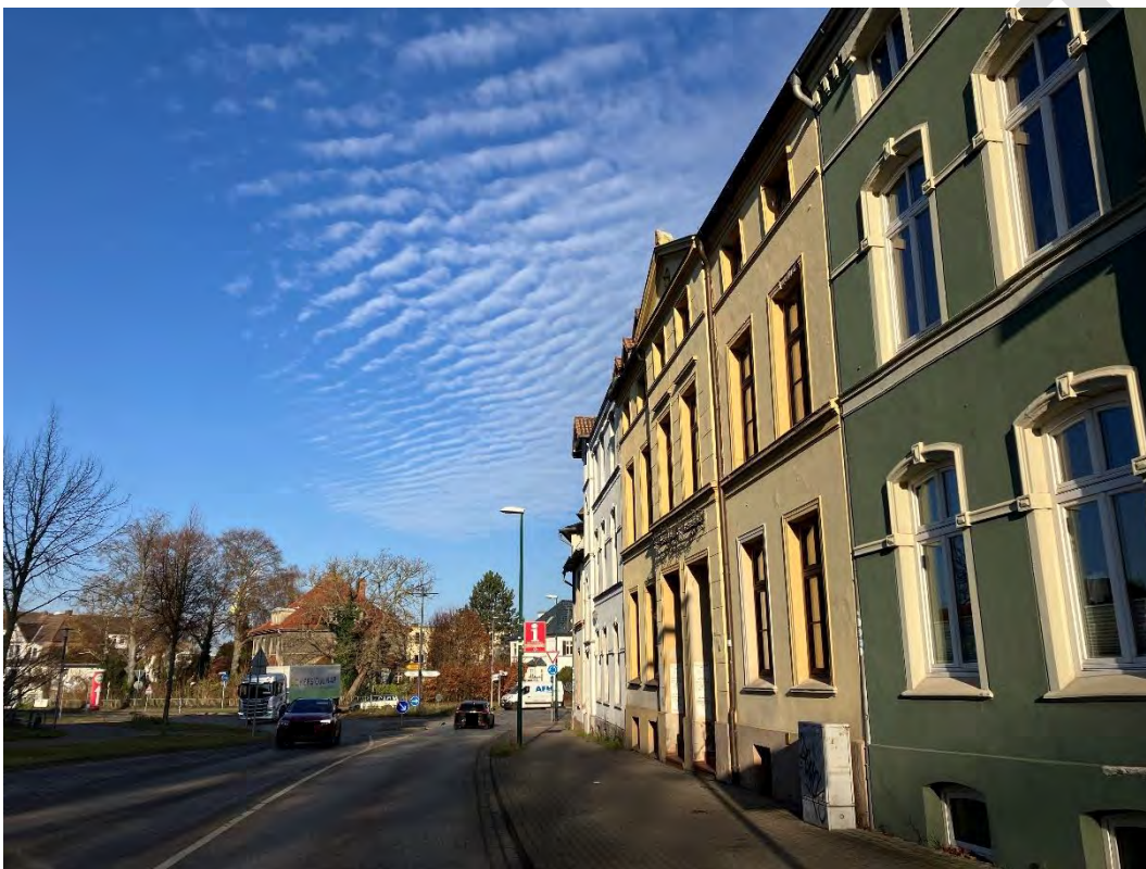
Abbildung 4: Lärmbetroffene Gebäude Dahlmannstraße
