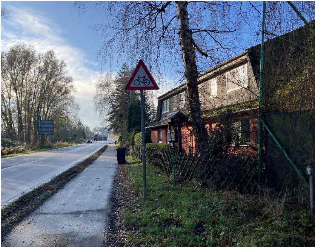
Abbildung 9: Lärmbetroffenes Gebäude B 208
