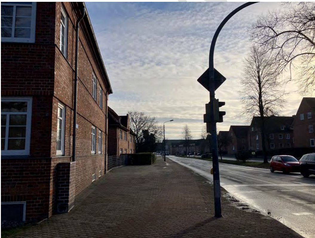
Abbildung 11: Lärmbetroffene Gebäude Bürgermeister-Haupt-Straße
