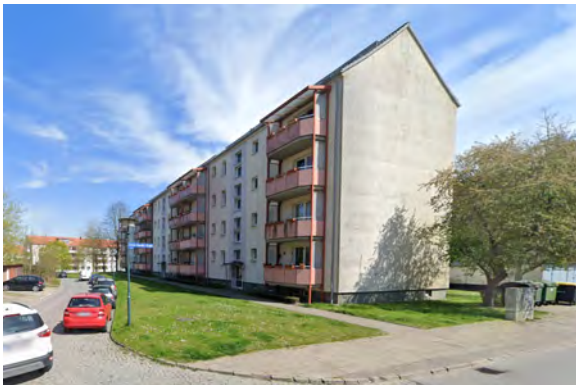
Abbildung 16: Beispiel Mehrfamilienhaus - Wendorf; Quelle: Google Maps
