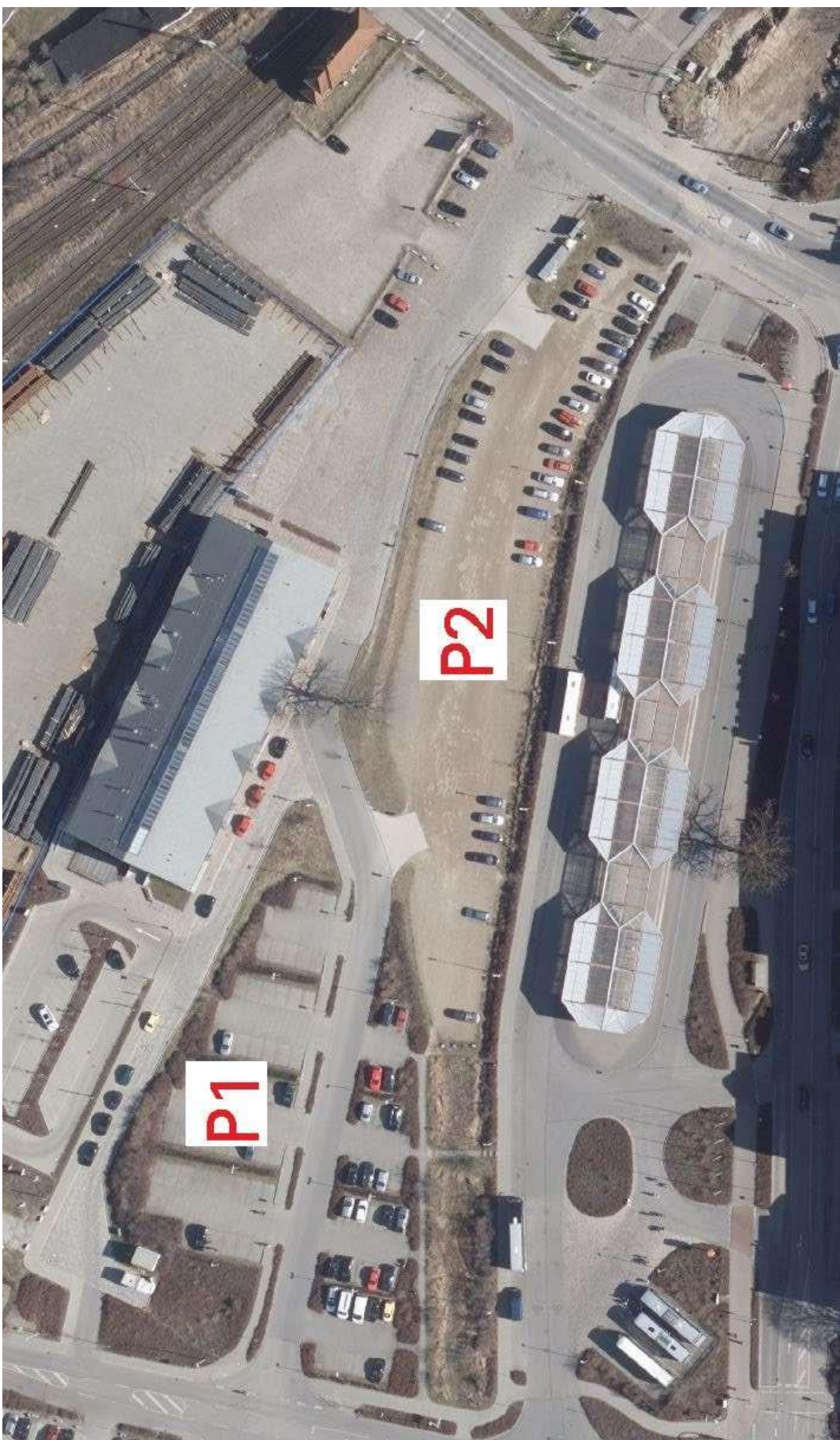
Anlage PP Altstadt/Bahnhof/ZOB
