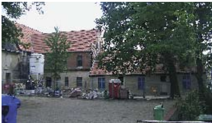
Baustelle Mecklenburger Straße 36 c2-f
