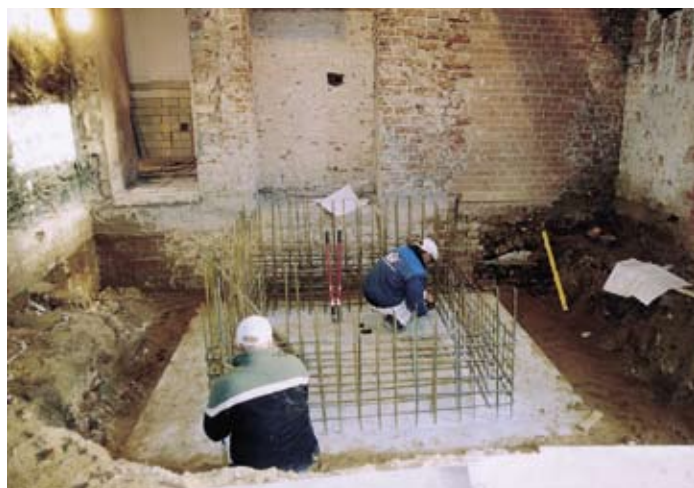
Haus d, Einbau eines Fahrstuhles
