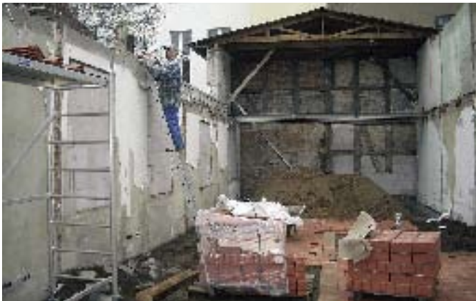
Abbruch des Hofgebäudes
