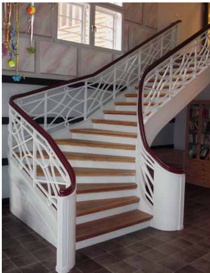
Filigranes Geländer, Treppe Lübsche Straße 44
