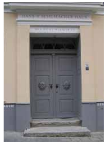
Haustür nach der Sanierung
