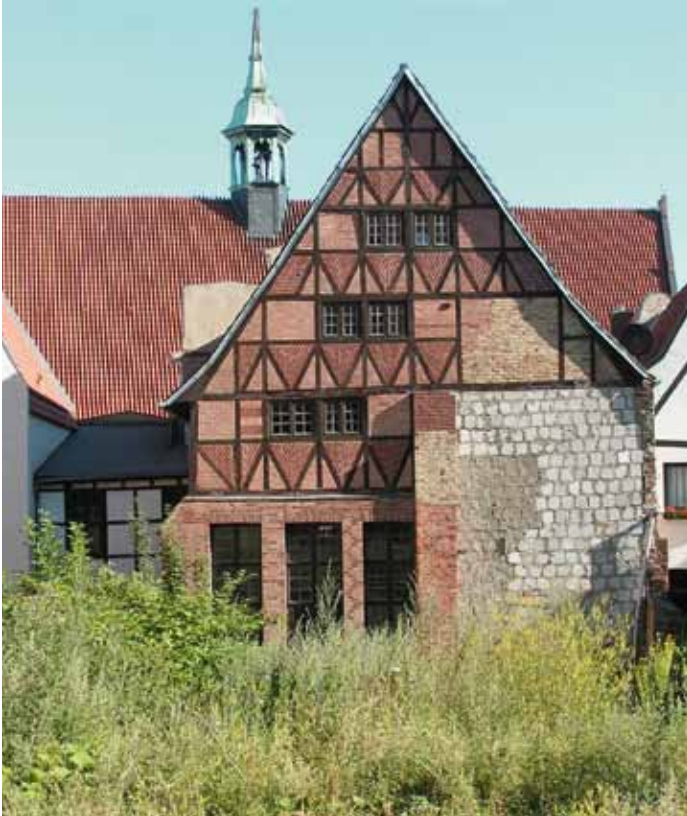
Rückfassade vor der Sanierung
