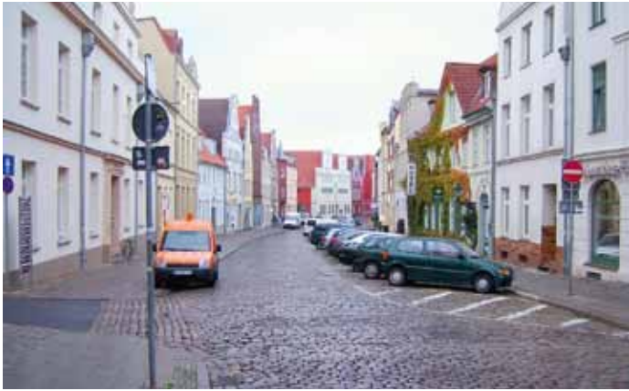
Vor der Sanierung von der Claus-Jesup-Straße bis zur Neustadt
