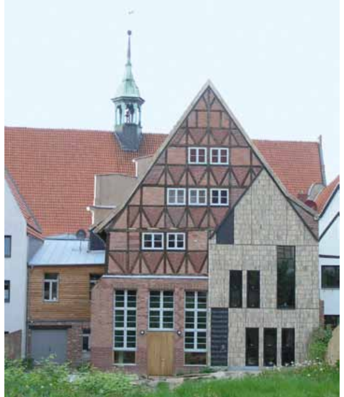
Rückfassade nach der Sanierung
