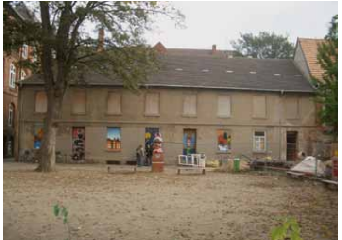
Zustand Mecklenburger Straße 36 a, b, c1
