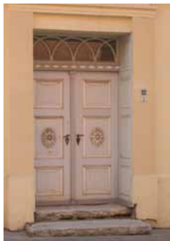
Haustür vor der Sanierung
