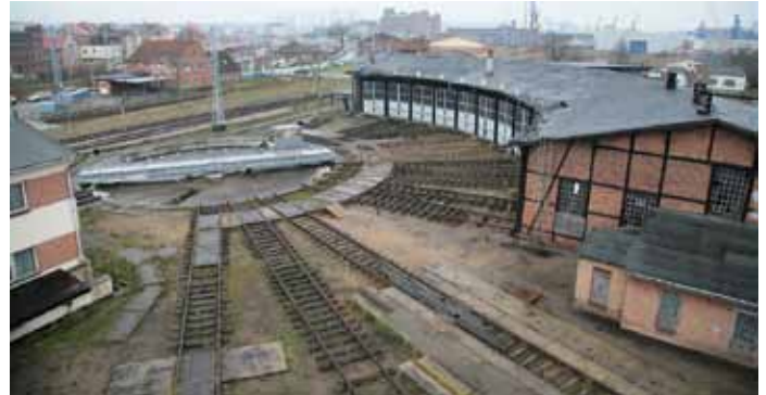
Lokschuppen und Drehscheibe, November 2008
