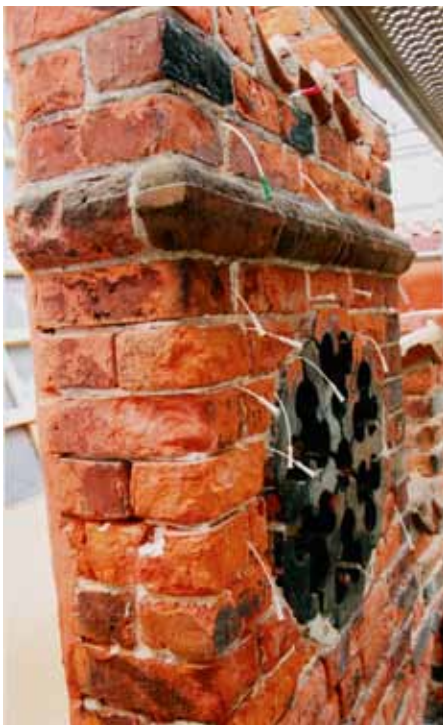
Hohlraumverfüllung des Mauerwerkes
